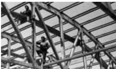
Aspecte de la construcció de la nau de l'empresa SAIFA. Procedència: arxiu familiar de Rosa M. Masana.
