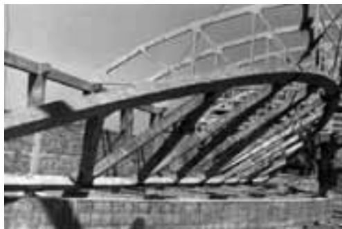
Un encavallat a punt de ser enlairat. Procedència: arxiu familiar de Rosa M. Masana.
