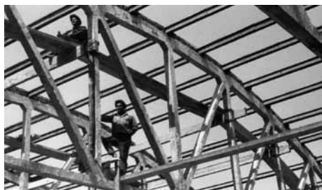
Aspecte de la construcció de la nau de l'empresa SAIFA. Procedència: arxiu familiar de Rosa M. Masana.
